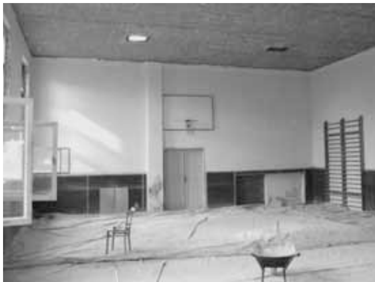
Oprava stropu v sokolovně.
