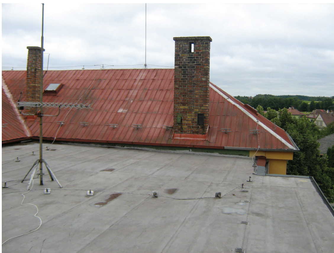
Funkční komín – oprava spár, omítnutí, oplechování vrchu komínu.
