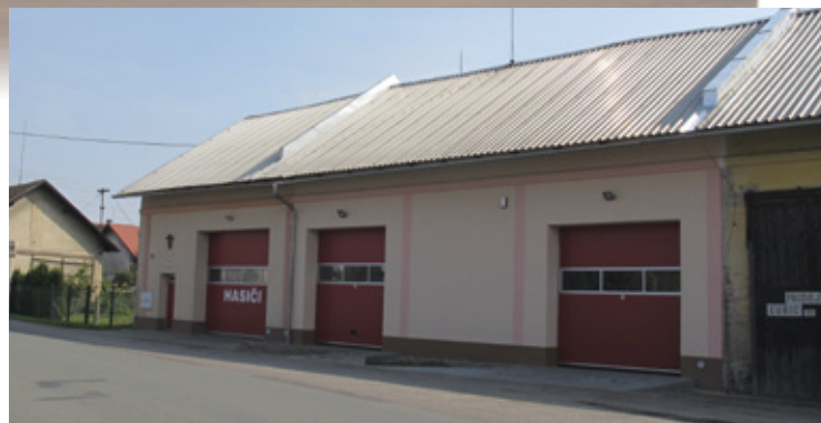
▲ Nově vybudovaný sklad protipovodňových prostředků
