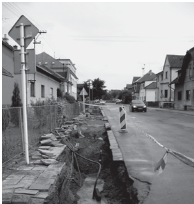
▲ Výměna vodovodního potrubí v ulici 1. Máje
