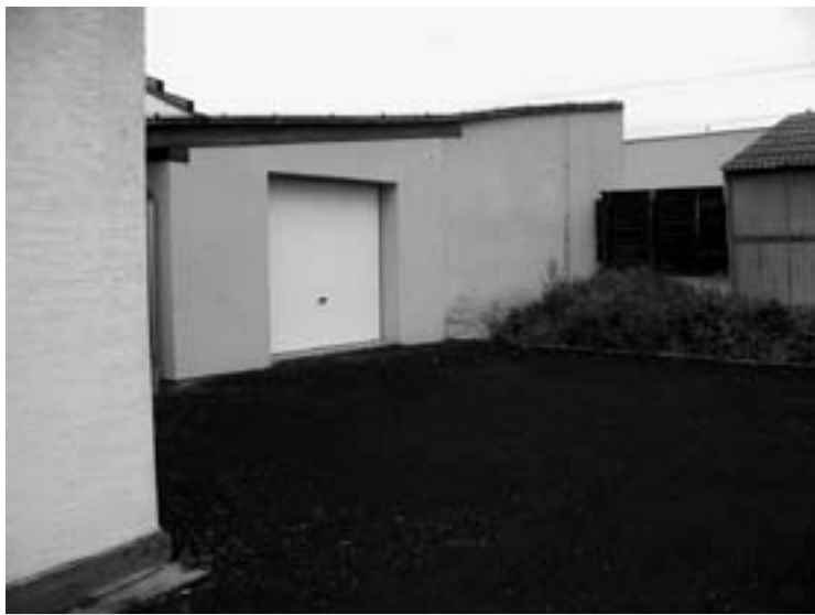
▲ Nová garáž pro obecní techniku
