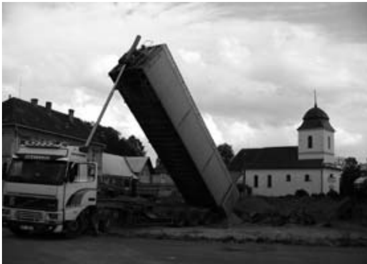
▲ Překladiště materiálu stavby „Výměna azbestocementového vodovodního potrubí“
